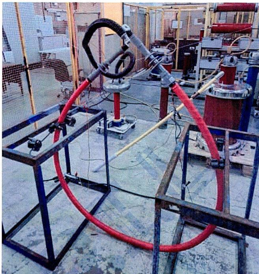
شکل ۲. تجهیز تحت آزمون تخلیه جزئی
