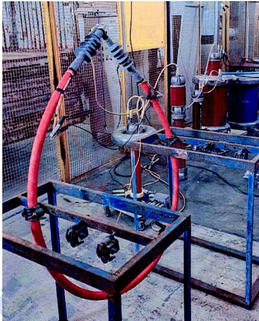
شکل ۲. تجهیز تحت آزمون تخلیه جزئی
